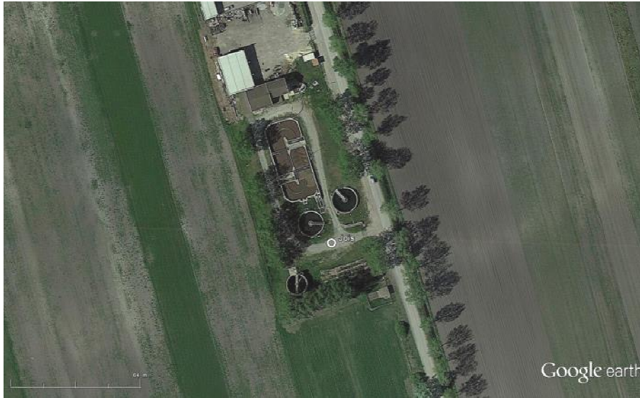
Abb. 79: Luftbildaufnahme der Kläranlage Jois.
