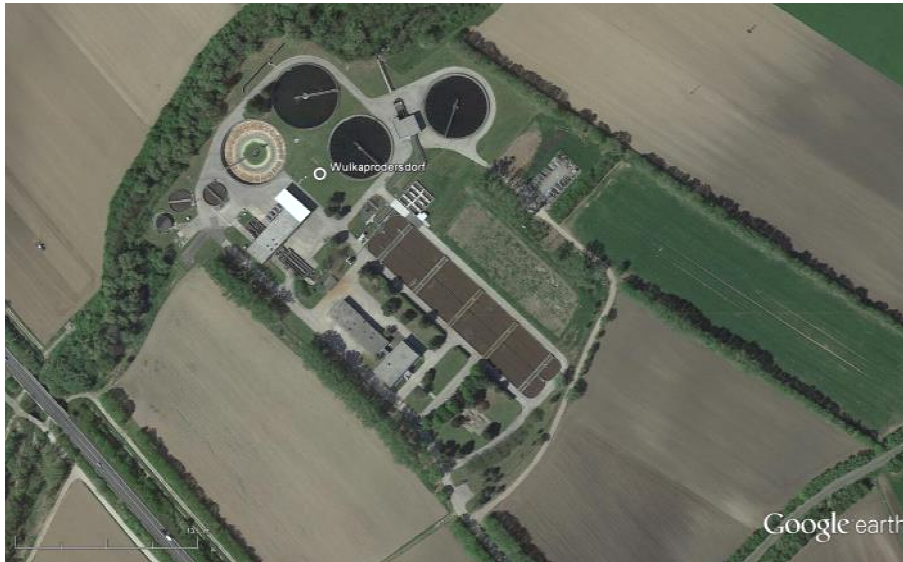
Abb. 76: Luftbildaufnahme der Kläranlage Wulkaprodersdorf.
