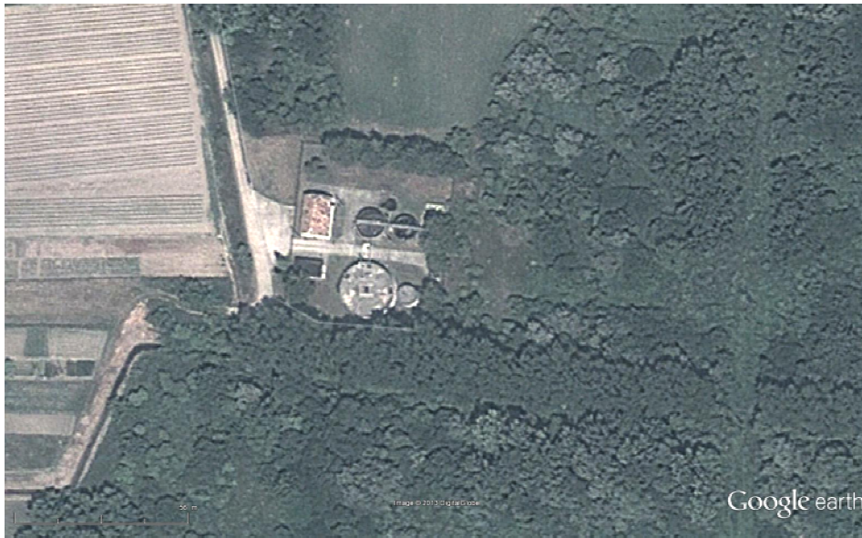
Abb. 82: Luftbildaufnahme der Kläranlage Balf.
