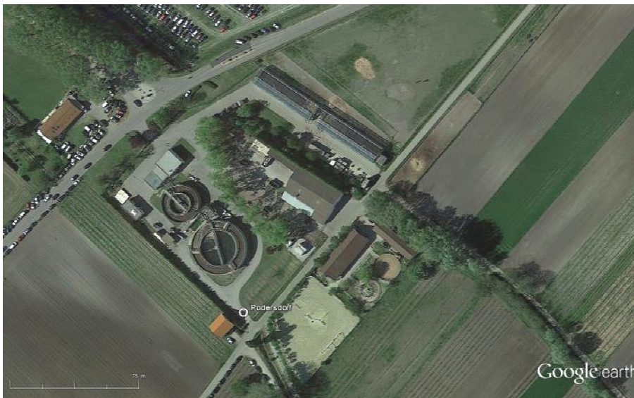
Abb. 81: Luftbildaufnahme der Kläranlage Podersdorf.
